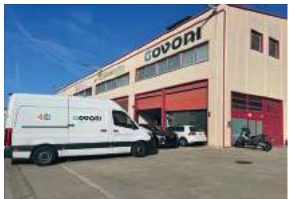
DISTRIBUTION CENTRE Barcelona, Spanien
