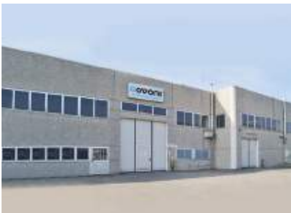
DISTRIBUTION CENTRE Crevalcore, Italien
