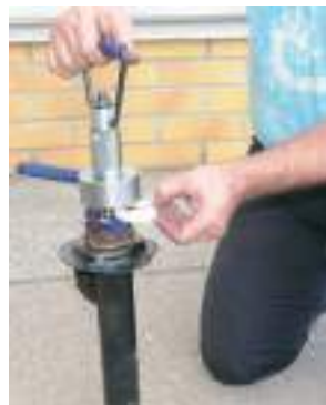
In den entstandenen Zwischenraum zwischen Klemme und Teleskop-Aufnahme wird nun nach Bedarf eines oder beide Distanzstücke platziert
